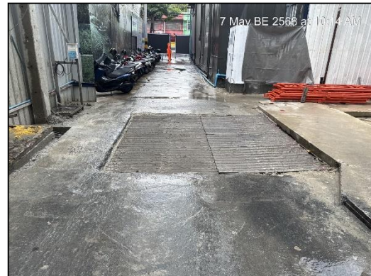
ภาพที่ 10 พื้นที่ล้างล้อรถบรรทุก
