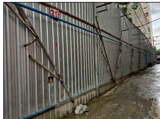
ภาพที่ 3 รั้ว Metal Sheet สูง 6 เมตร
